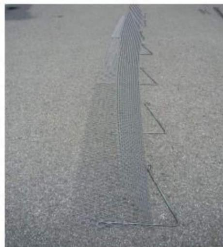
②本体を、短尺側を底面にして1網目重ね（継ぎ目）ながらセットします
