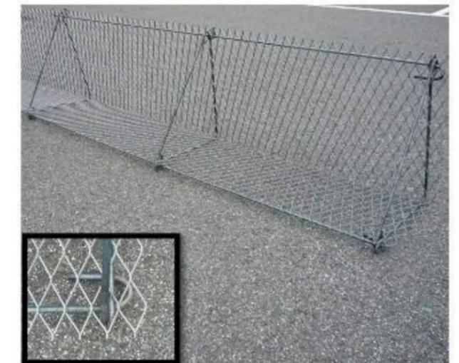
⑤補剛材と縦バタを合わせた下端部の輪に、横バタを通します
