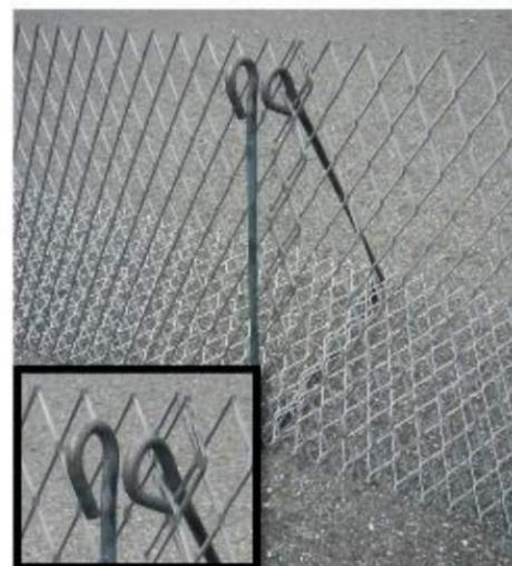
③補剛材を起し、重ねた継ぎ目の孔に縦バタを通して、補剛材の両端と縦バタの両端を合わせます
