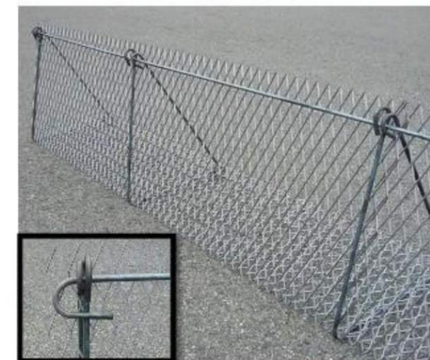
④補剛材と縦バタを合わせた上端部の輪に、横バタを通します
