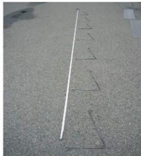
①補剛材を、短尺側を底面にして90cmピッチに配置します
