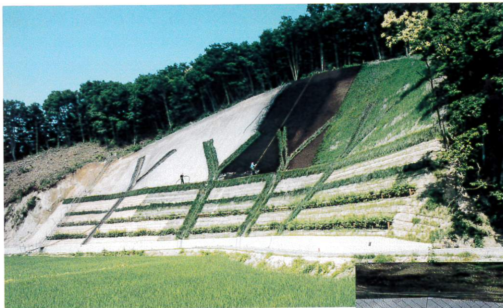
① 林道法面工事の水路工
