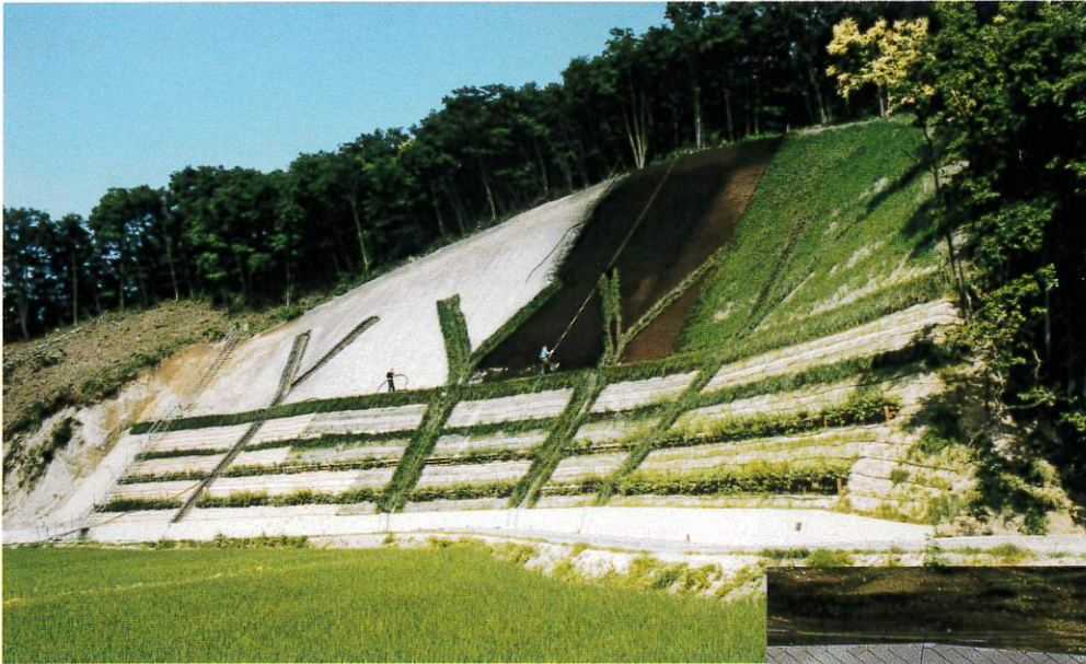
① 林道法面工事の水路工
