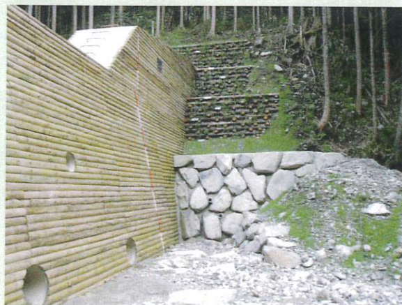
(下流から見た右袖囲い状況)
