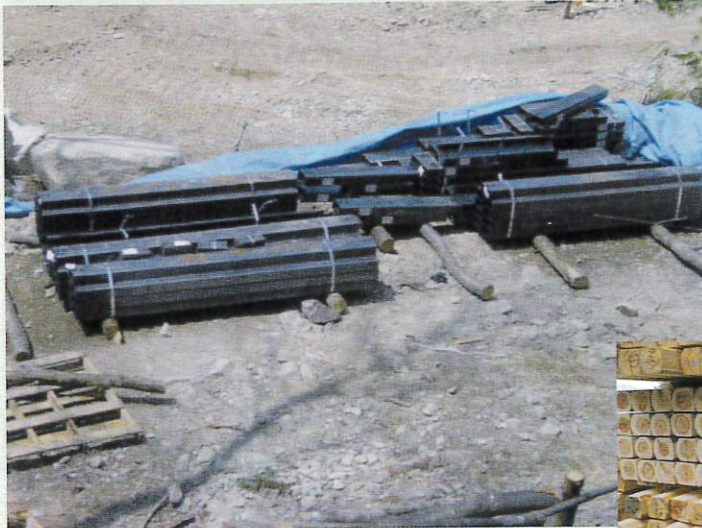
(現場搬入した鋼材部材)
